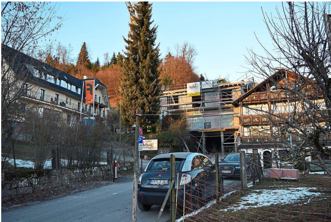
Der Rohbau steht. Er soll mit der noch folgenden Anbindung das Murgtalblick Betreuungszentrum mit dem früheren Landhotel Jägerstüble verbinden. Fotos: Michel Foto: Schwarzwälder Bote
