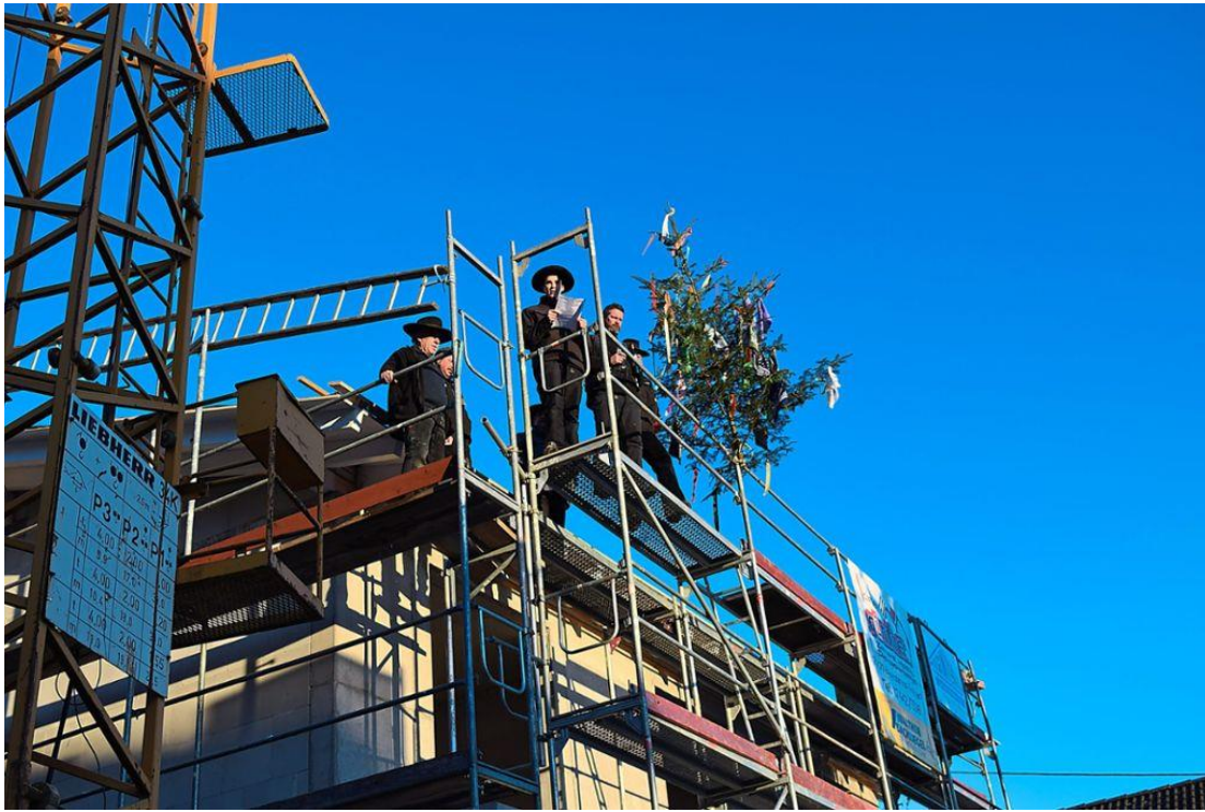
Die Zimmerleute von der Zimmerei Günther aus Tonbach bei ihrem Richtspruch. Foto: Schwarzwälder Bote
